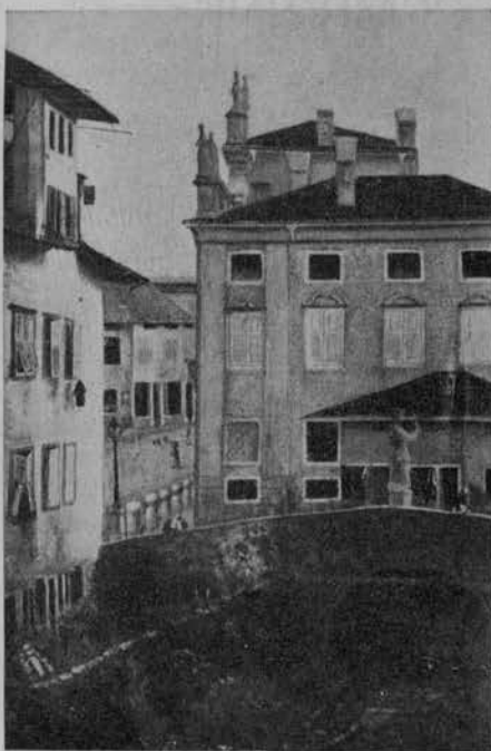
Il ponte sul Corno
