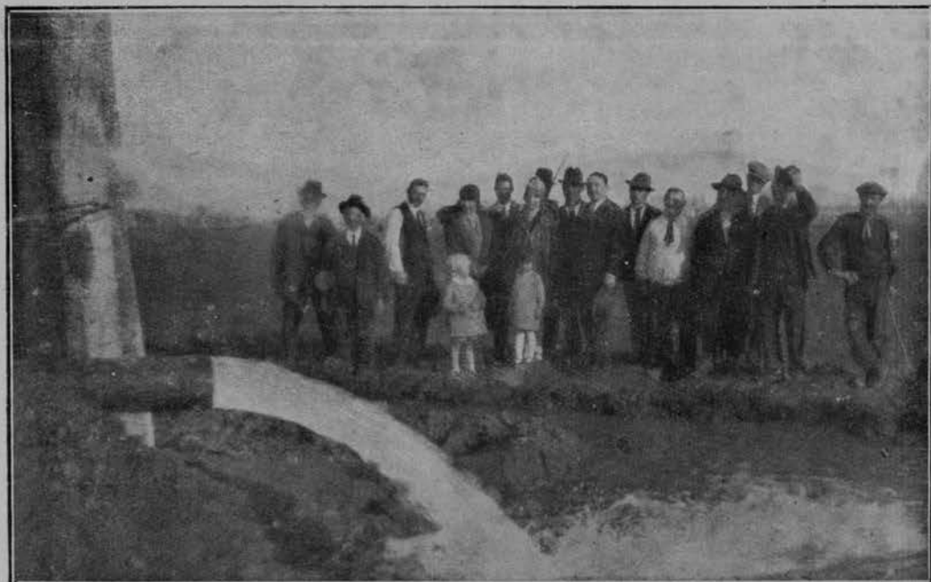
Fig. 2. — Pozzo di Santena in Regione Campassi (Torino) Prof. 25 m. - Portata 50 litri al 1" — Ditta F. Saracco (1929).
